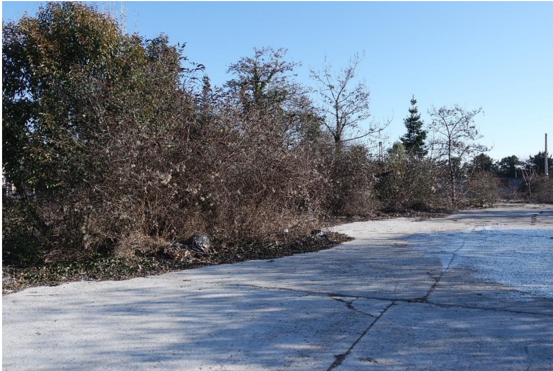
Piazzale e vegetazione dell'area abbandonata
